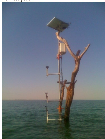
Figura 23. Torre de instrumentação.
