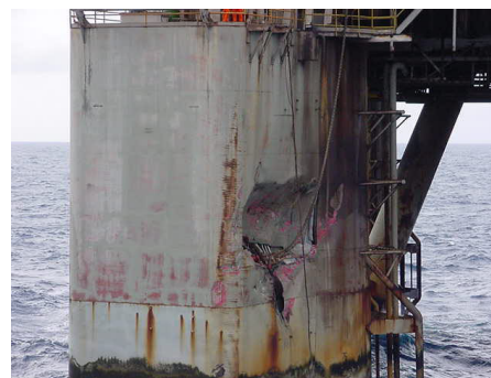
Figura 2 - Colunas de Plataforma Semi Submersível atingida por rebocador.
